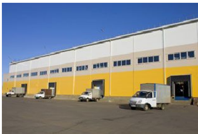
Рис. 5. Автоматические ворота склада (dock shelters)
