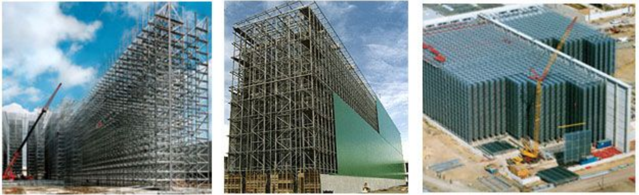
Рис. 49. Строительство автоматизированной складской системы
