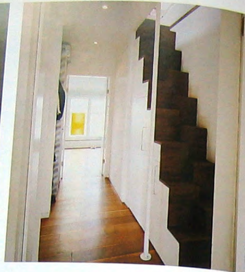
An aptly named 'Samba' staircase, a special, narrow flight of stairs, leads to the music studio. ■ Zum Musikstudio führt sinnigerweise eine so genannte Sambatreppe, eine schmale Spezialstiege mit versetzten Stufen. ■
