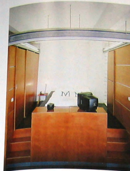
Because of the service supply pipes and cables, the bed stands on a platform in a compartment that can be closed off by a sliding door. ■ Das Bett steht, wegen der Nutzleitungen, auf einem Podest in einer durch eine Schiebetür verschließbaren Box. ■
